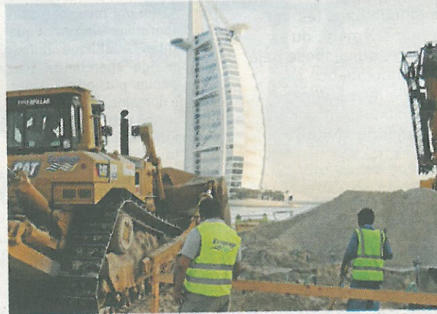
Au pied du célèbre hôtel Burj El Arab de Dubaï, Ecoplage a installé son système de drainage sur 950 mètres afin de lutter contre l'érosion de la plage.
