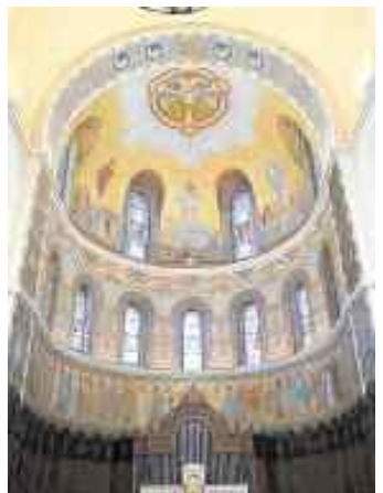
Les fresques du chœur de l'église Saint-Pierre ont notamment été rafraîchies lors des travaux en hiver 2007.
