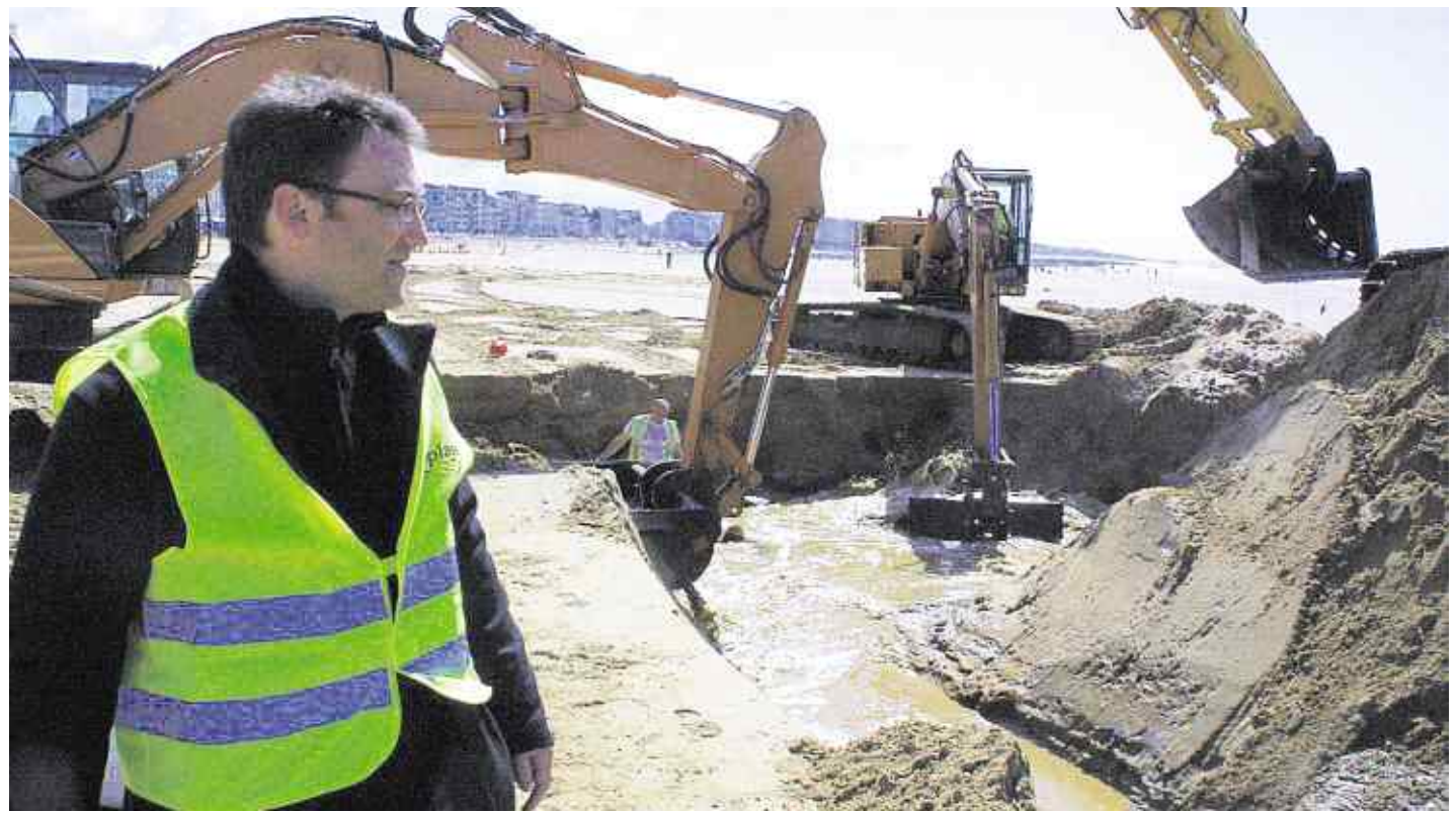
Les Sables a adopté en 1999 le système Écolage. 600 mètres de drains sont enterrés pour assécher les zones humides et ainsi lutter contre l'érosion en fixant le sable... Le système avait été mis hors service par les engins de travaux publics lors du remorquage de l' Artemis . Les pelleteuses sont revenues sur la plage hier et ont réalisé une immense tranchée de 2 m de profondeur sur 5 m de large.
