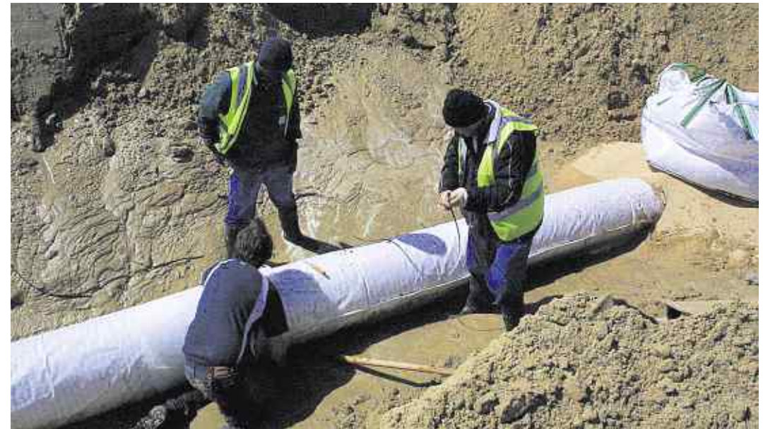
Il a été procédé au remplacement des canalisations défectueuses sur une portion de 32 mètres de long.
